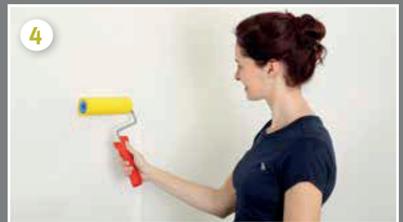
Blasen- und faltenfrei mit Tapezierbürste oder Moosgummirolle andrücken.
