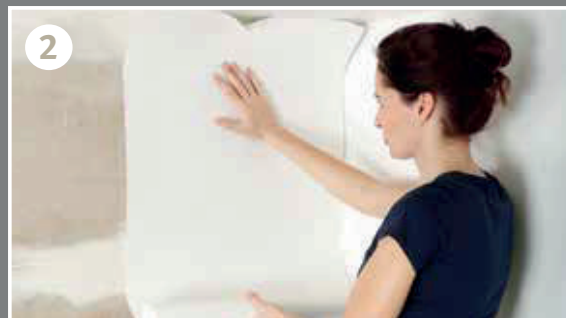
2 ... Variovlies direkt von der Rolle in das Kleisterbett einlegen.
