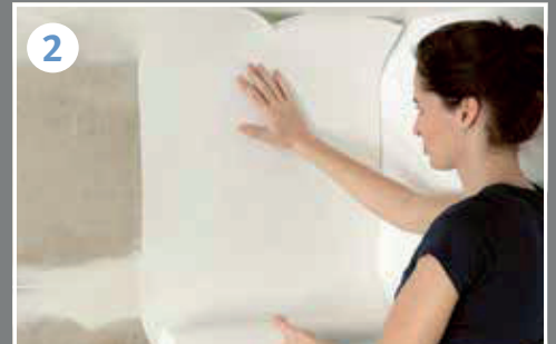
2 ... die Vliesfaser Protect direkt von der Rolle in das Kleisterbett einlegen.
