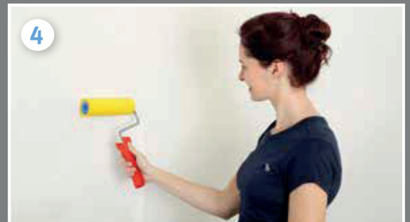
4 Blasen- und faltenfrei mit Tapezierbürste oder Moosgummirolle andrücken.
