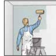
2b.使用墙壁涂胶技术无需浸胶时间铺贴。
