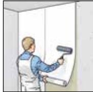
4.使用橡胶辊压平墙纸卷。
