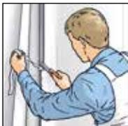
6.在墙角和边缘处，将墙纸卷切开并将之后的墙纸卷铺贴好。
