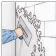
**1.** Odstranite stare tapete in premaze. Grobo podlago zgladite s kitom na osnovi mavca. Močno vpojne podlage grundirajte z osnovnim premazom, ki ne vsebuje topil.
