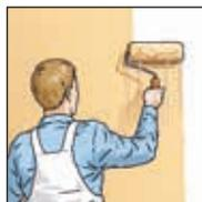
**7.** Po sušenju prepleskajte s kakovostno disperzijsko barvo, ki ustreza standardu DIN EN 13300, ali npr. z ometom, tapeto itd.
