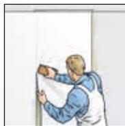
**7.** ERFURT-Novaboss lijepite jednu uz drugu. Istisnite mjehuriće i nabore tapetarskom četkom ili valjkom od spužvaste gume.
