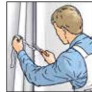
**6.** In Ecken und an Kanten wird nicht überlappend tapeziert, sondern die Trennung erfolgt exakt auf der Kante.
