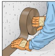
**2.** Entkopplungsband zur akustischen Entkopplung umlaufend an Wandanschluss und an allen beweglichen Bauteilen, wie z. B. schwimmender Estrich, Fenster, etc. anbringen.
