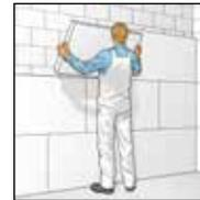
6. Klimaplatte übereinander versetzt (mind. 20 cm) mit mäßigem Druck an die Wand anpressen. Kreuzfugen und Lücken vermeiden. Überschüssigen Kleber an den Rändern entfernen.
