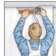
**7.** In den Ecken wird die Trennung mit dem Tapezierspachtel und einem Cuttermesser oder mit einer Schere ausgeführt.
