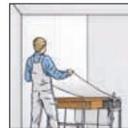
**3a.** Zur Verklebung wird Vlieskleber im Ansatz 1:10 verwendet. Im Kleistergerät ohne Weichzeit oder
