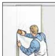
**7.** ERFURT-Novaboss Naht an Naht verkleben. Blasen- und faltenfrei mit Tapezierbürste oder Moosgummirolle andrücken.
