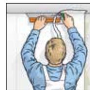
**5.** Излишки у потолка, плинтусов, окон и т. д. удалить с помощью монтажного ножа и обоейного шпателя.
