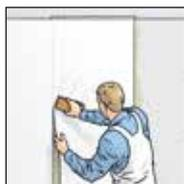
**3.** Выровнять полотна вертикально по отвесу и наклеить встык.
