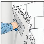
**1.** Удалить старые обои и покрытия. Шероховатые основания выровнять гипсосодержащей шпаклевкой. На сильно впитывающие основания нанести грунтовку, не содержащую растворителей.
