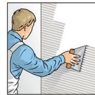
**2b.** Bei mittel bis grob strukturierten Untergründen ERFURT-Systemkleber SR 4 mit einem Zahnspachtel (B2 oder C3, je nach Untergrund) gleichmäßig quer zur Laufrichtung direkt auf die Wandfläche auftragen.
