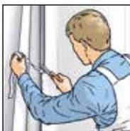
**7.** An Außenecken wird nicht überlappend tapeziert, sondern die Trennung erfolgt exakt auf der Kante.
