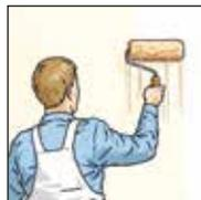
**8.** Laibungsplatte mit Kleister grundieren (nur bei Tapezierungen).
