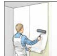
**9.** Laibungsplatten sind ohne Armierung mit allen diffusionsoffenen Wandbelägen, Putze und Beschichtungsstoffe etc. überarbeitbar.
