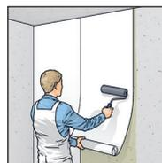
**4.** Blasen- und faltenfrei mit Gummirolle oder Tapezierbürste andrücken. **In keinem Fall einen Nahtroller verwenden!**
