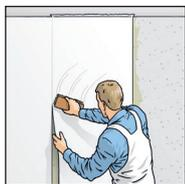
**3.** Die Bahnen präzise Naht an Naht, passend im Rapport und im Lot ansetzen. Verschieben im Kleisterbett minimieren. Kleisteraustritt großflächig sofort mit einem weichen feuchten Schwamm behutsam abtupfen.
