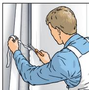
**7.** На внешних углах не наклеивать полотнища внахлест, а обрезать точно по краю.
