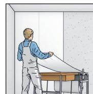
**2b.** Нанесение клея с помощью клеенамазочного станка: пропустить полотна через клеенамазочный станок и обрезать.
