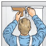
**6.** Излишки обоев в углах обрезать ножницами. Профессионалы также обрывают обои, прижав их шпателем..
