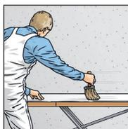
**2a.** Нанесение клея вручную: нарезать полотнища длиной, соответствующей высоте стены плюс припуск, нанести клей на каждое из полотнищ. Или
