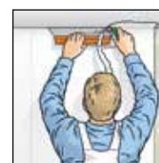
4. Полотнища ERFURT-KlimaTec Thermovlies стик в стик накладаються повстяною стороною на вологий системний клей ERFURT і розгладжуються дрібнопористим гумовим валиком або шпалерним шпателем.
