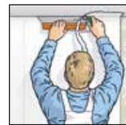
**6.** Излишки обоев ERFURT-KlimaTec Thermovlies у потолка и пола прижимаются шпателем для обоев и аккуратно обрезаются монтажным ножом.
