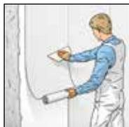
**4.** Полотнища ERFURT-KlimaTec Thermovlies стык встык накладываются войлочной стороной на системный клей ERFURT и разглаживаются валиком из мелкопористой резины или обойным шпателем.
