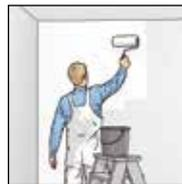
**2.** Le support doit être propre, sec, stable et absorbant. Enlever d'abord les supports non solides.
