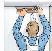
**6.** Überstehendes ERFURT-KlimaTec Thermovlies an der Decke und dem Boden mit einem Cuttermesser oder einer Hakenklinge mittels eines Spachtels oder einer Schneidchiene sauber abtrennen.
