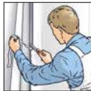
5. 超出外角部分使用工具刀或钩刀切割干净。为达到优良的外角稳定，推荐在ERFURT-KlimaTec Thermovlies墙纸上使用塑料角边。
