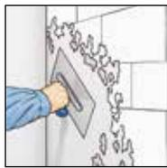
1. 去除旧墙纸及涂料。粗糙不平的基层需用含石膏的填充物进行平整。具有强吸收性的基层墙面使用不含溶剂的打底色打底。
