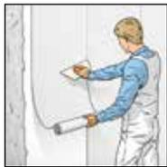
4. 将ERFURT-KlimaTec Thermovlies墙纸以毡面并排铺贴到湿润的ERFURT系统胶液上并使用橡胶辊或者塑料刮铲将气泡压出。
