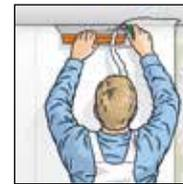
6. 天花板及地面处超出的ERFURT-KlimaTec Thermovlies墙纸使用工具刀或钩刀通过刮刀或者切轨切割干净。
