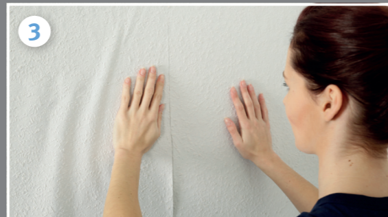
3 Die Bahnen auf Stoß, Naht an Naht, im Lot verkleben. Nicht überlappend verarbeiten.
