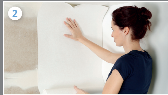
2 ... die Vliesfaser Ready direkt von der Rolle in das Kleisterbett einlegen.
