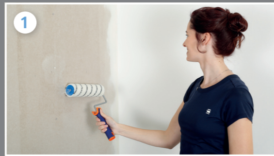
1 Wand einkleistern und ...
