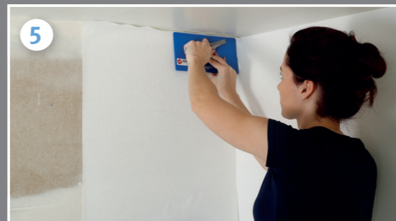
5 Überstände mit einem Kunststoffspachtel in die Ecke drücken und mit einem Cutter-Messer beschneiden.
