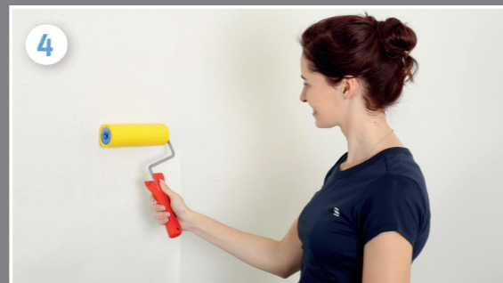
4 Blasen- und faltenfrei mit Tapezierbürste oder Moosgummirolle andrücken.
