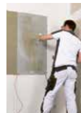
3. Systemkleber SR 6 PRO drückt sich durch das perforierte Vlies.
