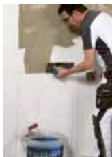
1. Systemkleber SR 6 PRO mit Zahnzug C1 aufziehen.
