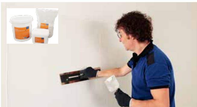
Akustik-System mit Klimaplatten, Akustik Grundputz und Akustik Oberputz
