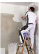
4. Fläche mit Systemkleber SR 6 PRO glatt spachteln.
