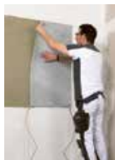
2. Carbon-Heizvlies in das Kleberbett legen.
