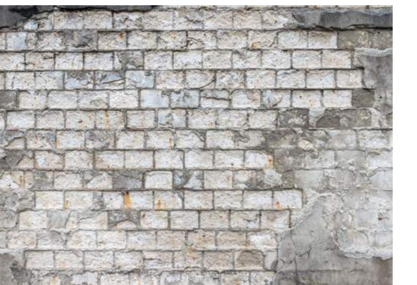
Mur de briques silico-calcaires | 666
