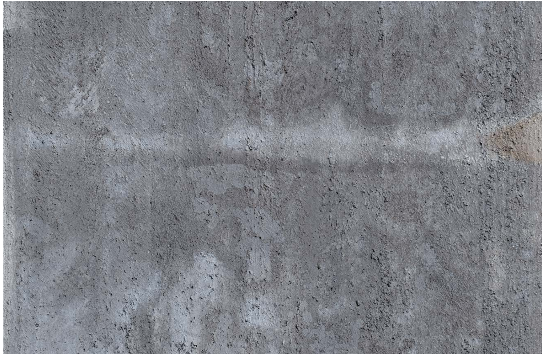
675 | STRUCTURE EN BÉTON
