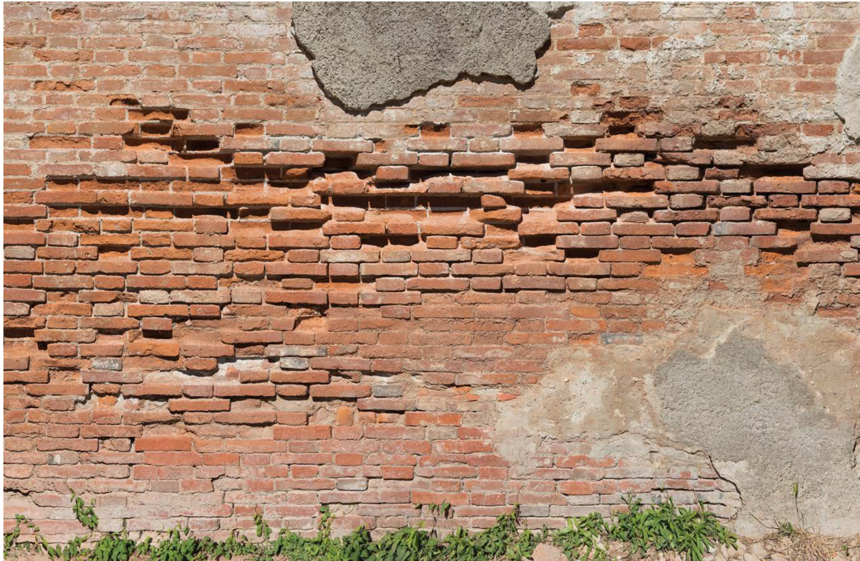
661 | VIEUX MUR DE BRIQUES
