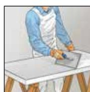
5. С помощью зубчатого шпателя / кельмы (зубцы не менее 8 мм) нанести клей по всей поверхности панели.
