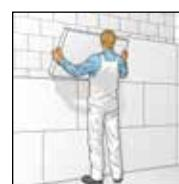
6. Панели для отделки проемов с умеренным надавливанием наложить на стену. Избегать крестообразных швов и зазоров. Выступивший по краям клей удалить.
