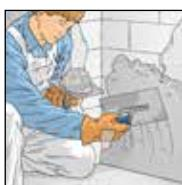
1. Трещины, отслоения и сильные неровности зашпаклевать системным kleem SR 6.
