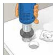
3. До начала монтажа с помощью кольцевой пилы вырезать отверстия для розеток.
