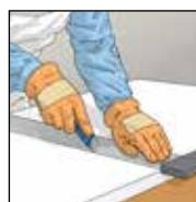
2. Панель для отделки проемов надрезать резцом и отломить по линии надреза или распилить пилой.
