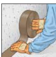
4. Закрепить разделительную ленту вдоль всей линии прилегания к стене и всем подвижным строительным конструкциям, например, «плавающему» полу, окнам и т. д.
