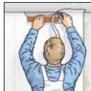
**5.** Überstehendes ERFURT-Variovlies Reno an der Decke und dem Boden mit einem Cuttermesser oder einer Hakenklinge mittels eines Spachtels oder einer Schneidschiene sauber abtrennen.
