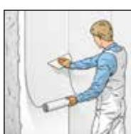
4. ERFURT-KlimaTec Thermovlies s filcanom stranom na rubu položiti u vlažno ERFURT-sustavno ljepilo i pritisnuti špatulom za tapaciranje ili sunderastim gumenim valjkom da se istisnu mjeđurići.
