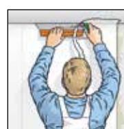
6. ERFURT-KlimaTec Thermovlies na stropu i podu odrezati čisto skalpelom ili kukastom britvom s špatulom ili šinom za rezanje.
