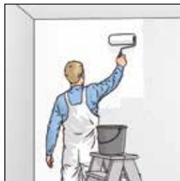
使用长柄辊以1卷轴的宽度满满的且均匀的将ERFURT-KlimaTec系统胶液涂刷到基层墙面上。
