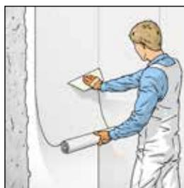
将墙纸放入胶床中并使用铺贴刮铲轻压，使胶液均匀的分配形成一理想基层墙面。
