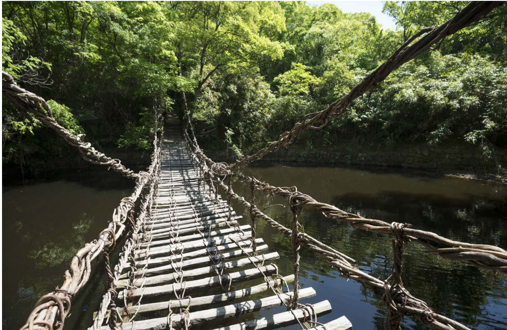
409 | HÄNGEBRÜCKE IM DSCHUNGEL
