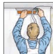
**5.** Излишки обоев у потолка, плинтусов, окон и т. д. удалить с помощью монтажного ножа, прижав обои шпателем.
