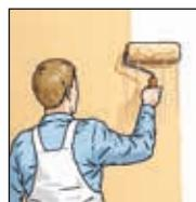
7. Nakon sušenja premažite visokokvalitetnom disperzivnom bojom prema DIN EN 13300 ili obložite npr. tapetom, gipsom ili sl..
