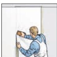
3. Staze lijepite jednu uz drugu u okomitom pravcu. Ištisnite mjehuriće i nabore tapetarskom četkom ili valjkom od spužvaste gume.
