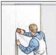
**3.** Coller les lés d'aplomb, bord à bord à joints vifs. Éliminer les bulles d'air et les plis à l'aide d'une brosse à tapisser ou d'un rouleau en caoutchouc.
