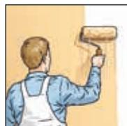
**7.** Après le séchage du papier, la surface doit être repeinte avec une peinture dispersion suivant DIN EN 13300 ou être recouverte d'enduit, de papier peint ou similaire.
