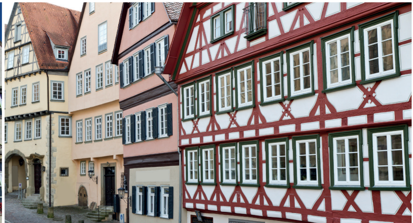
Denkmalgeschützte und erhaltenswerte Fassaden | Listed buildings and façades of historic interest
