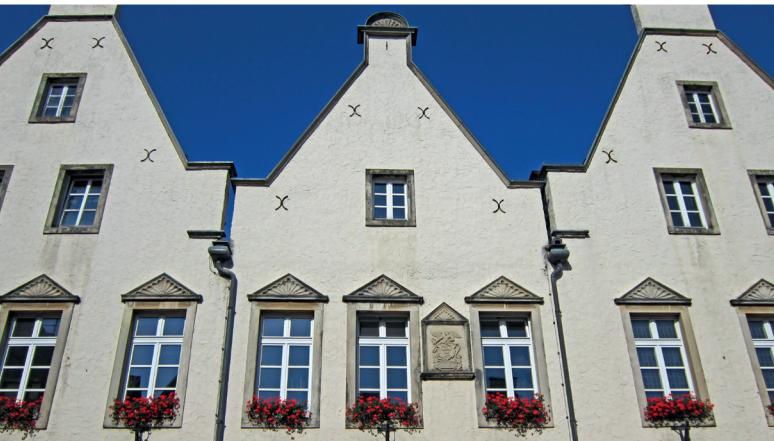
Gebäude mit fehlendem Dachvorsprung | Buildings with no roof overhang
