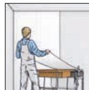
2b. U uređaju za premazivanje ljepilom bez omekšavanja. Za lijepljenje koristite ljepilo na bazi flisa.
