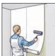
4. Stazu prilijepite na naneseni sloj ljepila bez mjehurića i nabora i pređite preko nje valjkom od spužvaste gume ili tapetarskom četkom.
