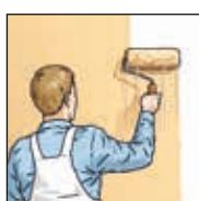
7. Nakon sušenja premažite visokokvalitetnom disperzijskom bojom prema DIN EN 13300.
