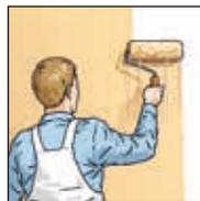
**7.** Nakon sušenja premažite visokokvalitetnom disperzivnom bojom prema DIN EN 13300 ili obložite npr. tapetom, gipsom ili sl..
